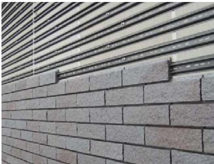
乾式レンガタイルの取り付け
