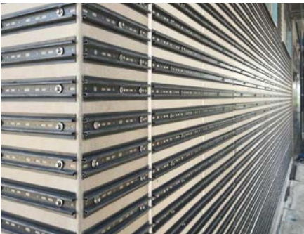
ECP 下地へのカーニバルレールの固定
